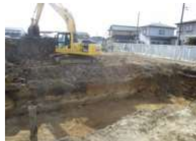
第2体育館南側のプール工事
