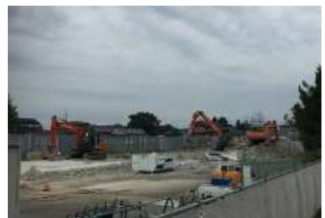
建物部分の解体を終えた旧小学校校舎
