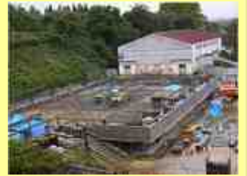
▲ 体育館工事の様子 (10月)
