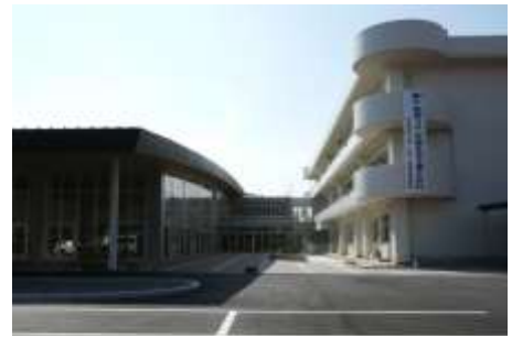
きれいに改修された中学校校舎（右）
