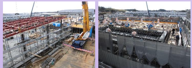
東側(左)と西側(右)から見た工事現場
