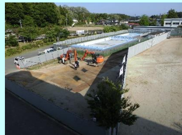
解体前のプール
