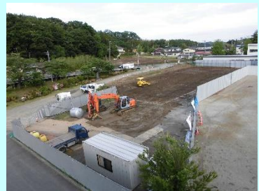
整地されたプール跡地
