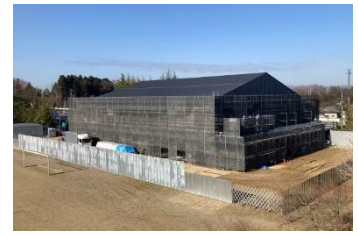
3月22日現在の体育館工事の様子
