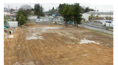
解体が終わり更地になった体育館跡地
