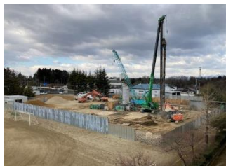
工事も順調です(2/28)
