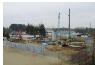
体育館解体工事の様子(2/14)
