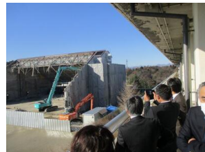
体育館解体工事見学
